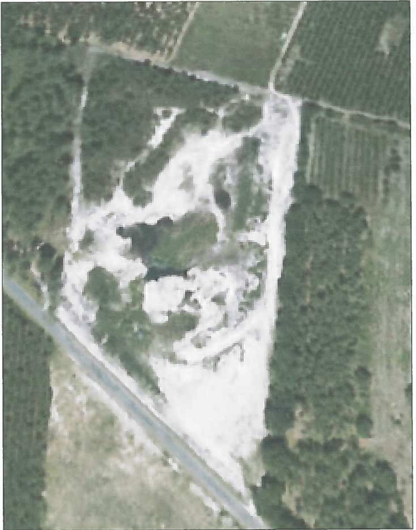
Le terrain a été en partie défriché et des granulats enlevés au Sud du site. Pas de déchets visibles (enlèvement ou enfouissement suite plainte de l'ADLG ?).
